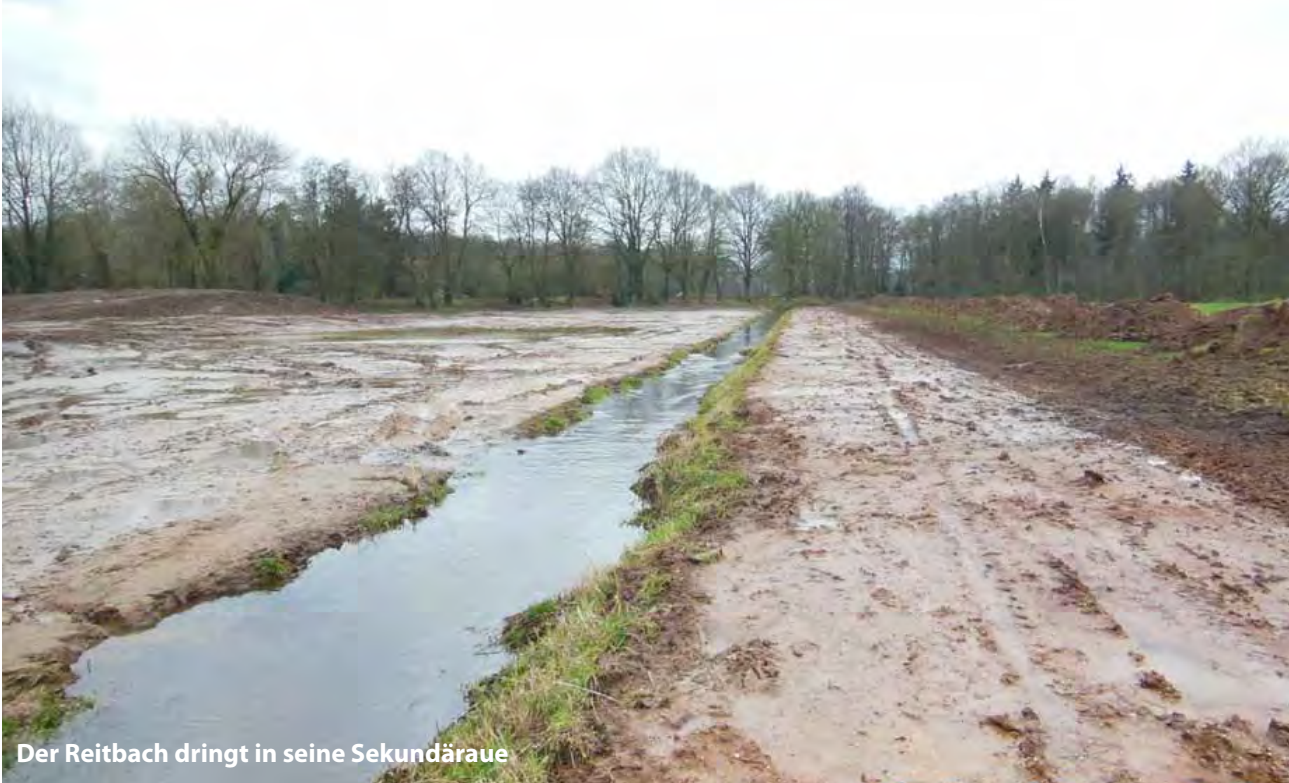
Beidseitiger Bodenabtrag in der Aue
