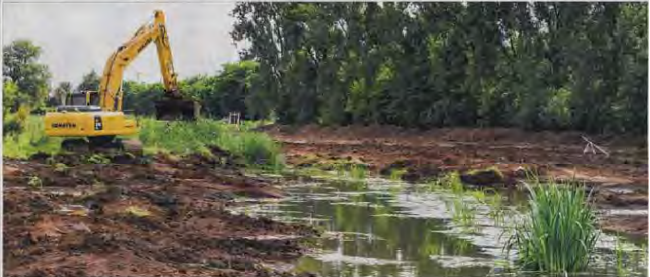
Wo einst ein schnurgerader Graben vor sich hin floss, schafft ein Bagger nun Platz für Schleifen und Mäander.
